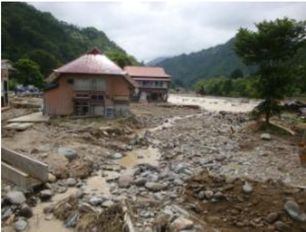
写真3：増水により流失被害を受けた家屋（叶津地区）
