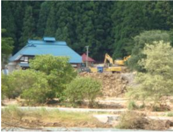
写真6：家屋から流入した土砂を取り除く復旧作業（熊倉地区）
