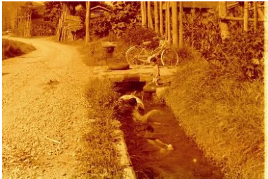
石伏?(昭和 63 年 7 月)
