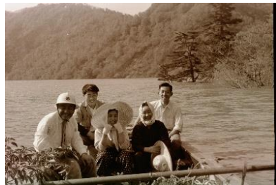
田子倉ダム建設時、測量をしていた町民(左から2番目男性)
