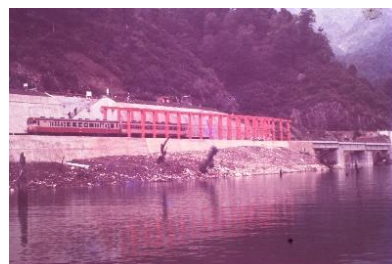
建設中の田子倉駅
