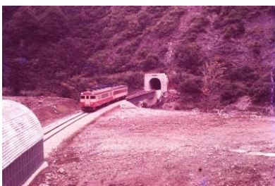
建設中の田子倉駅
