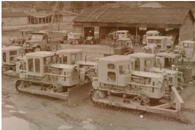
国道の常時開始時のブルドーザー一群(昭和35年11月)
